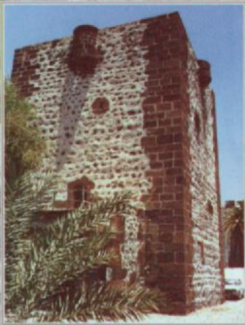
Torre del Conde, San Sebastián de La Gomera
